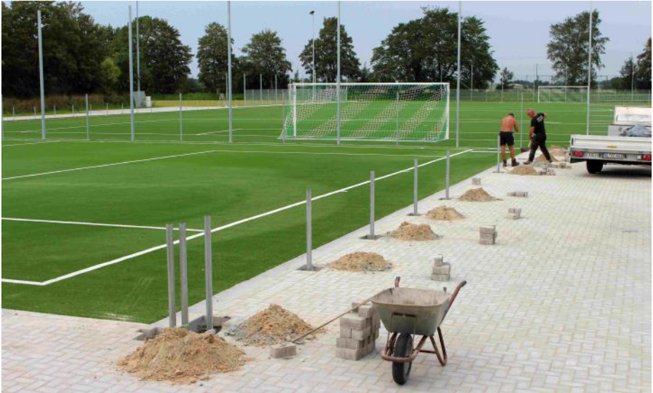
Pfosten setzen für die Spielfeldumrandung des Kleinfeldes (Kunstrasen)
